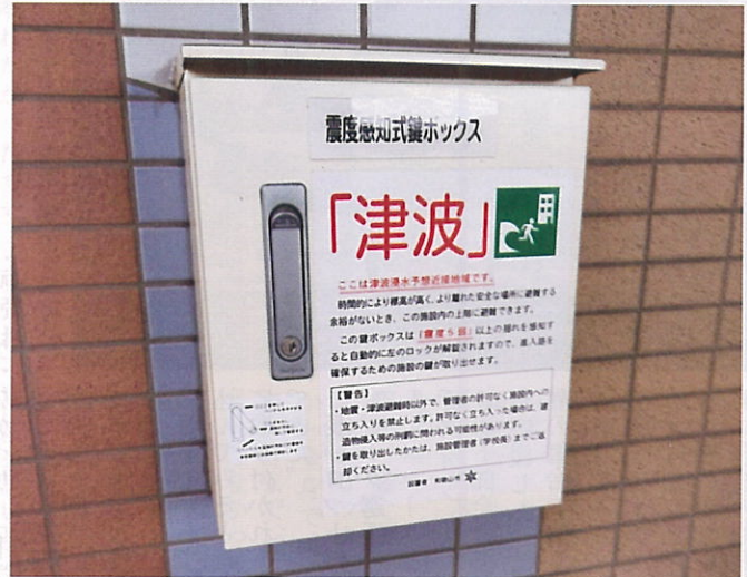
震度感知式鍵ボックス（本館入口左側に設置）
